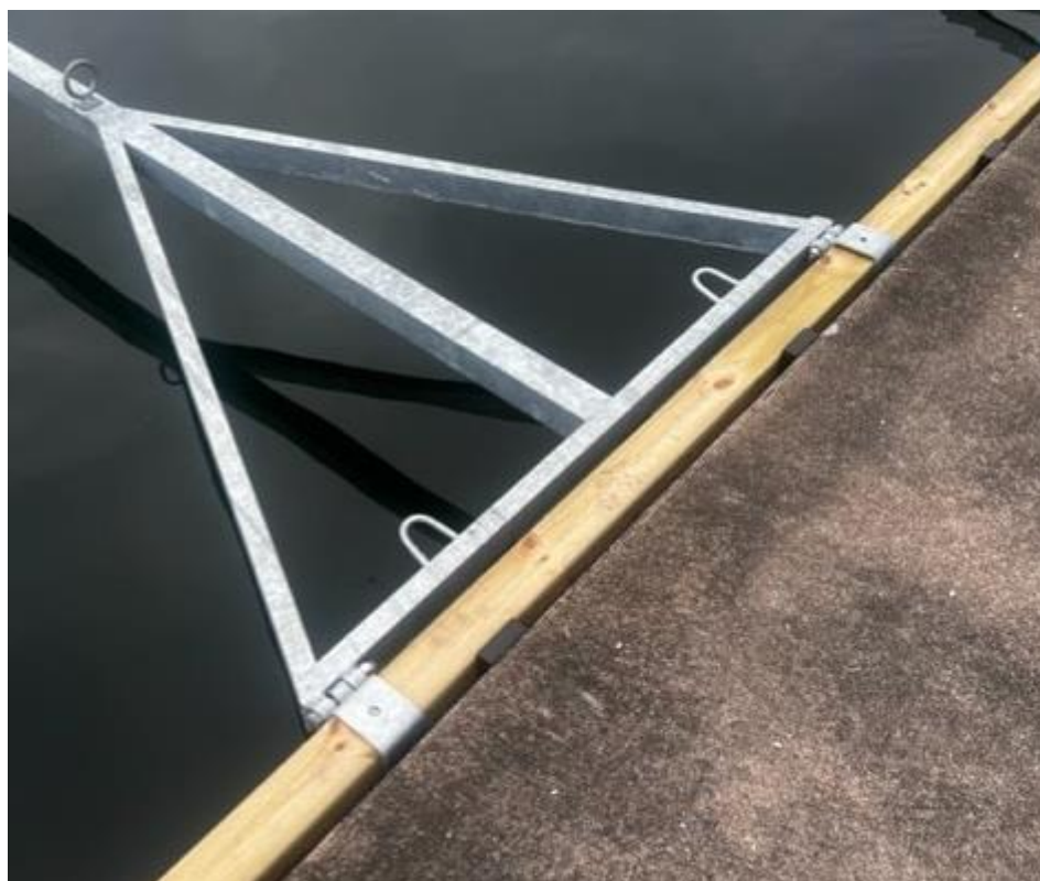
Bilde 2) Viser fortløyningsbom med klammerbeslag montert på betongbrygge med fenderstokk
