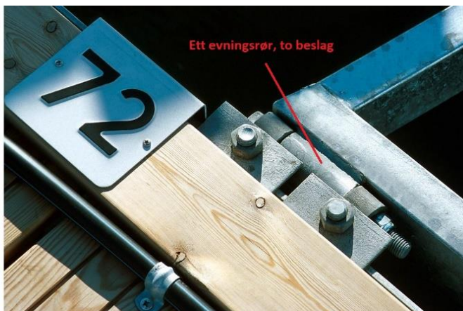
Bilde 2) Viser fortløyningsbom med klammerbeslag montert på betongbrygge med fenderstokk
